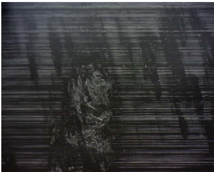
Imagem 9: Impressão da superfície antes da aplicação no gearbox da turbina eólica nº AB VIII – AEG 01
